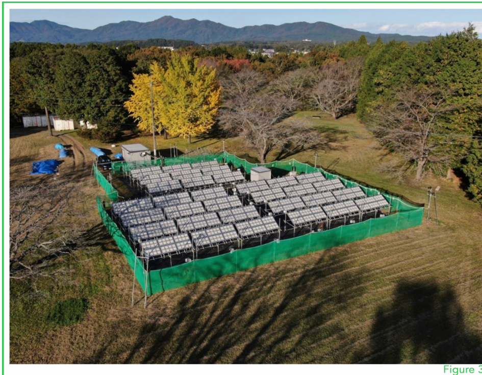
Figure 3. Photo aérienne d'un système photocatalytique de 100 mètres carrés pour la production de dihydrogène.
